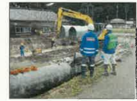
【復旧工事の状況】
