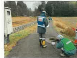
【農業集落排水施設の調査】
