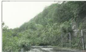
【表層崩壊箇所の現地状況】
