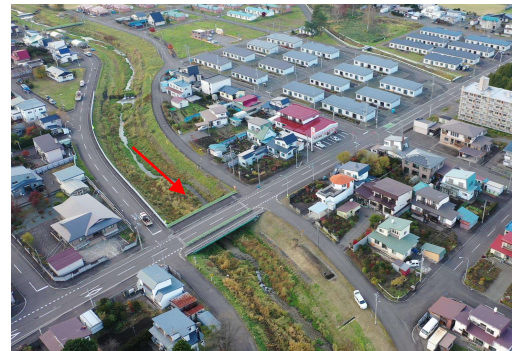
▲西1線橋付近上空より上流（下流部）
