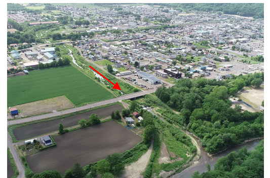
▲佐幌川合流点付近上空より上流（下流部）
