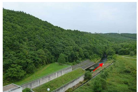
▲佐幌ダムより下流（上流部）
