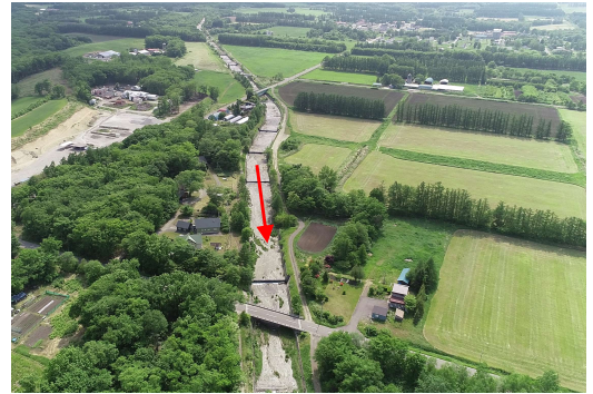
▲4号橋付近上空より上流（中流部）
