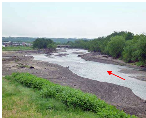
▲大成橋より下流（下流部）
