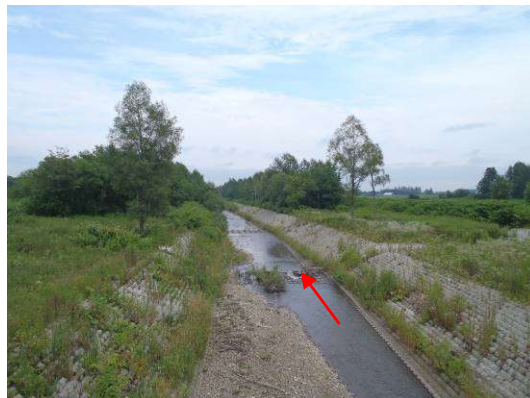
▲ 共栄橋より下流（上流部）
