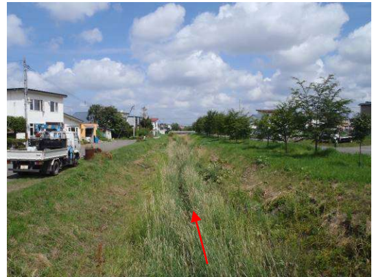
▲南10線橋より下流（上流部）
