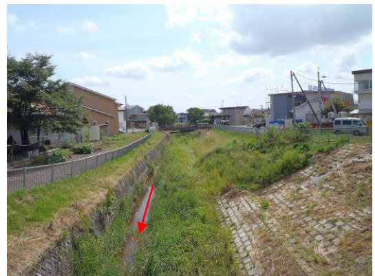
▲善隣橋より上流（中流部）
