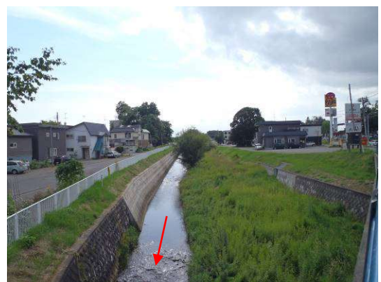
▲蹄橋より上流（下流部）
