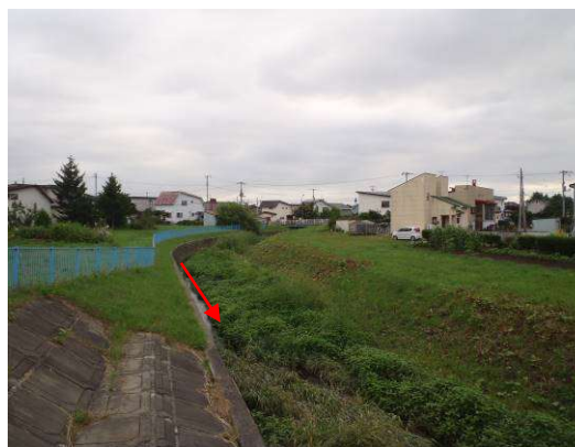
▲伏古別橋より上流
