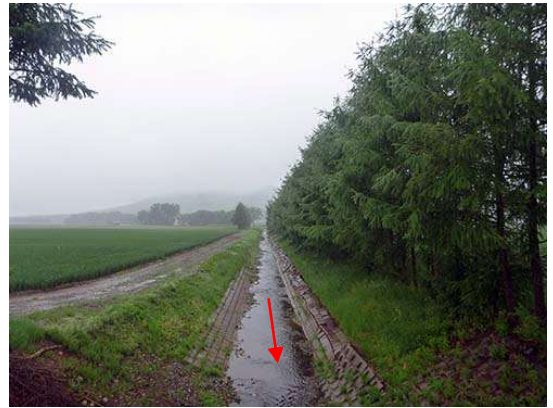
▲西美生橋より上流（上流部）
