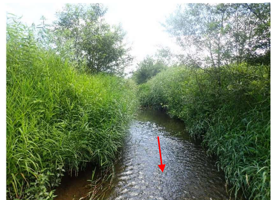
▲稔橋より上流の河道状況(下流部)
