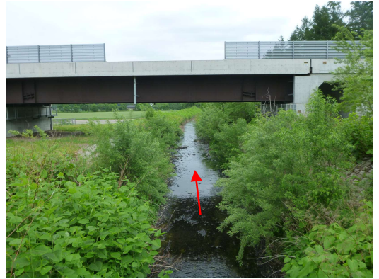
▲第11号橋梁より下流(上流部)
