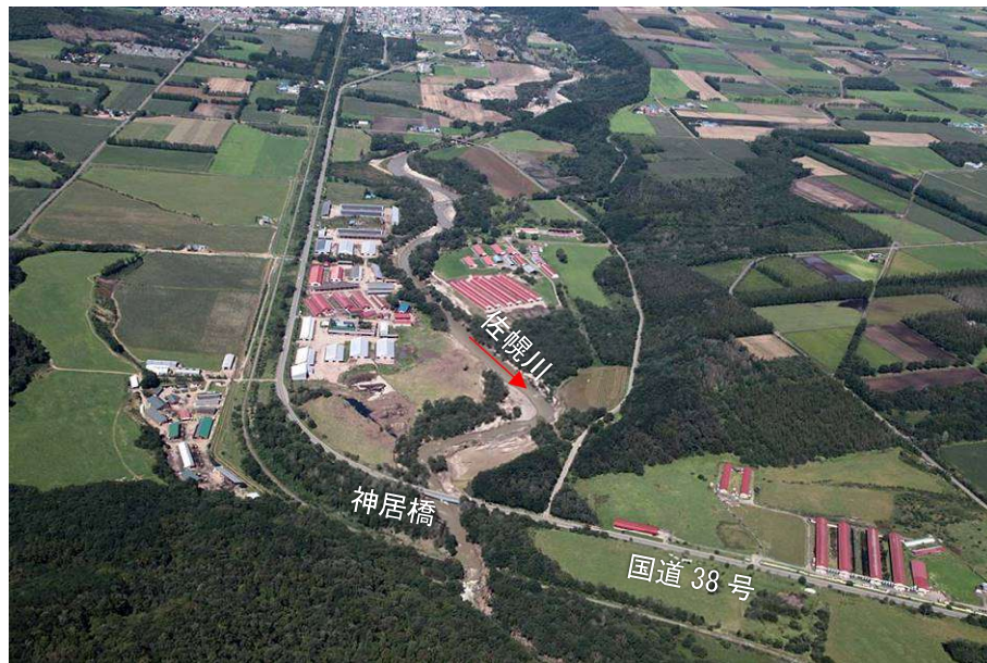
▲神居橋付近の被災状況 <平成28年8月>
