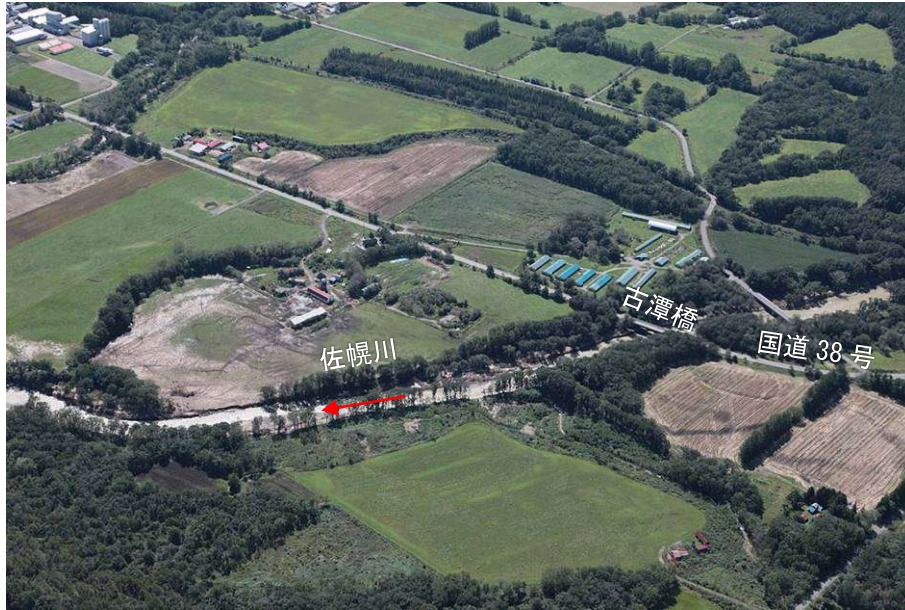
▲古潭橋付近の被災状況 <平成28年8月>
