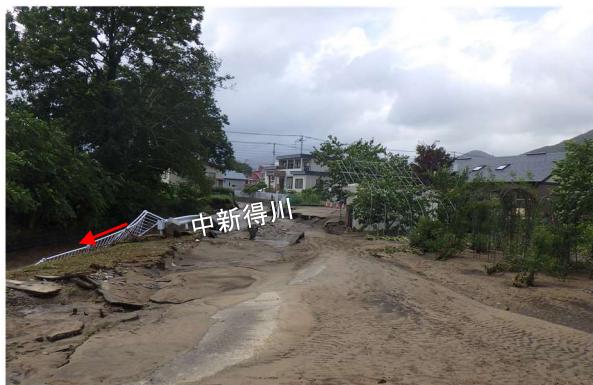
▲3条橋付近の被災状況
