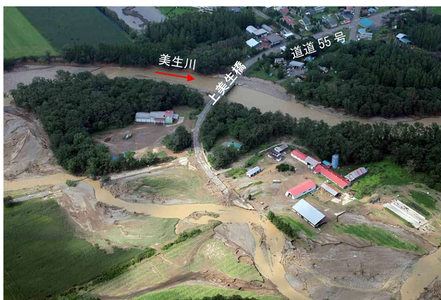
▲上美生橋付近の被災状況
