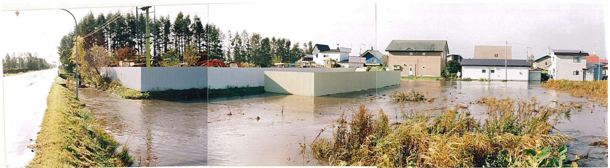
▲更新橋上流約10m地点 ＜平成14年10月＞
