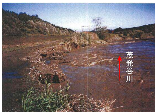
▲ホープランド橋下流左岸の氾濫跡 <平成14年10月>
