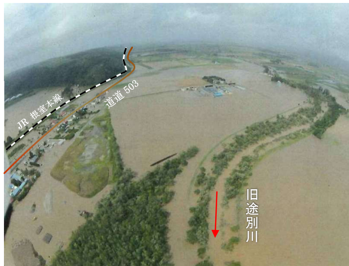
▲猿別川合流点上流の被災状況 <平成28年8月>
