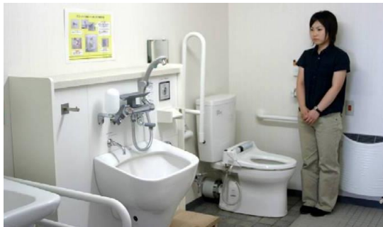
オストメイト対応トイレの設置(浦幌町)
