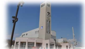
道の駅あしよろ銀河ホール21（足寄町）
