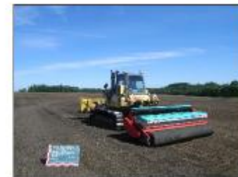
【施工状況】 圃場番号25-1-4-1 5%量地機作業後
