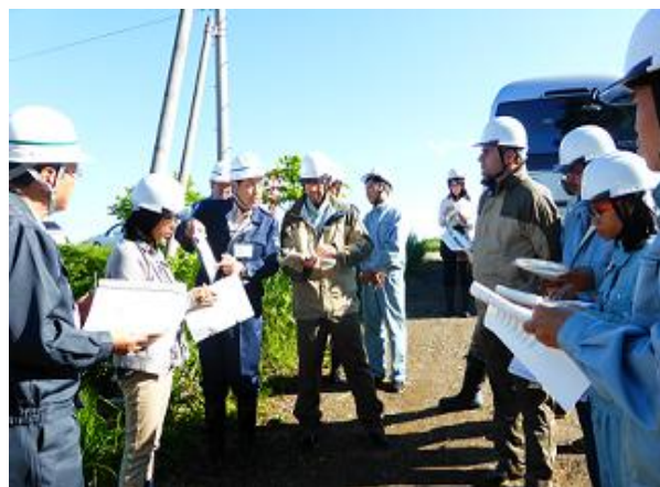
担当職員から施工方法の 説明を受けます
