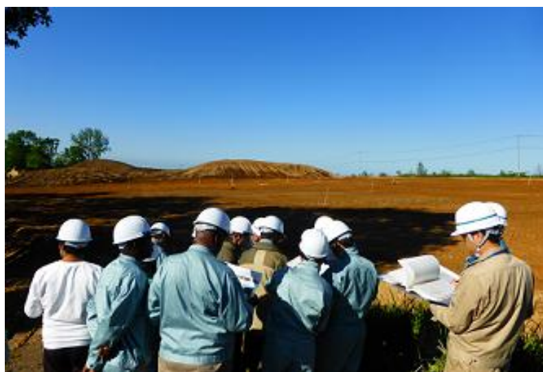
整地工の施工状況を確認 質問など積極的な姿が印象的でした
