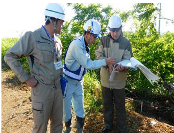
施工図面の確認。ご協力くださった 施工業者様にも感謝です
