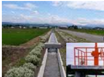
< 分水ゲート > 用水路の水を他の水路へ流したり量の調整を行う
