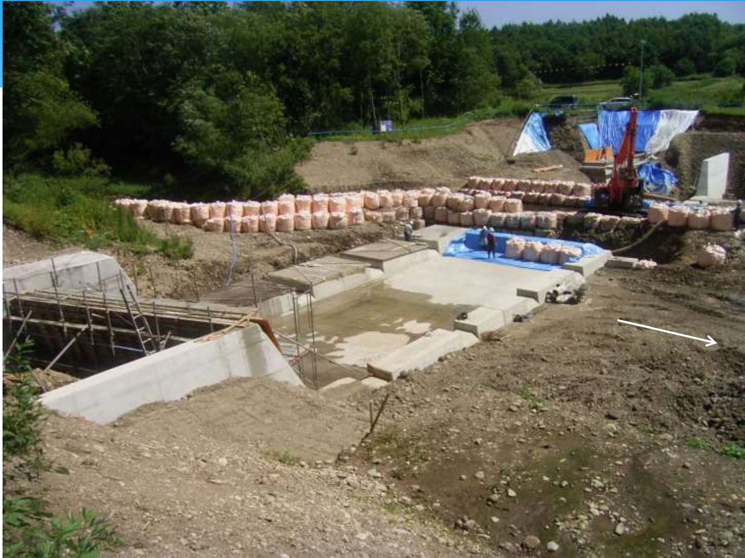
12号床固工 施工状況(H30.8.30)
