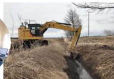
明渠補修を実施（実証圃に位置づけ）
